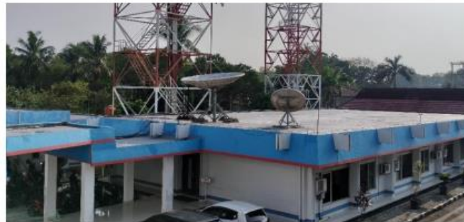
Gambar 7. Antena VSAT di Airnav Palembang Sumber: Kantor LPPNPI Palembang
