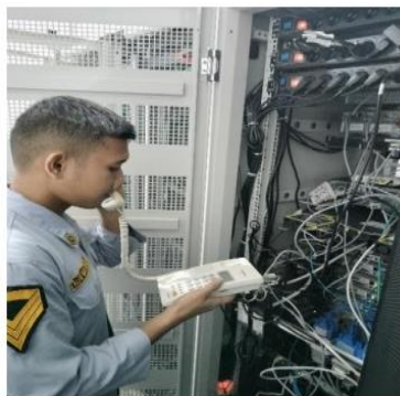
Gambar 13. Pengecekan Port Line DS Pada Card EHWIC
