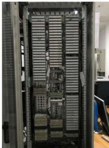
Gambar 5. MDF di LPPNPI Cabang Palembang Sumber: Kantor LPPNPI Palembang
