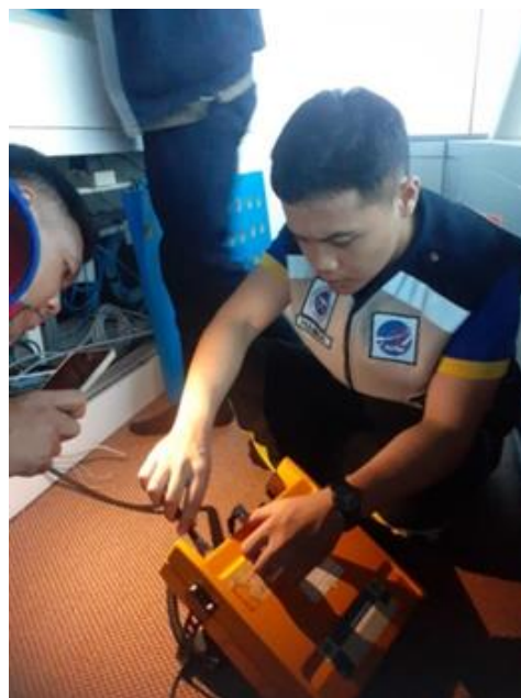
Gambar 8. Pemasangan radio VHF A/G Portable di Tower
